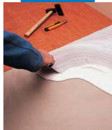
*Stesura di Adesilex V4 per la posa di quadrotte di PVC omogeneo*
